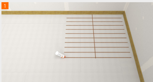
De lijmrillen aanbrengen.
