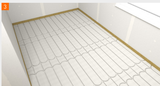
De ruimte dichtleggen met fermacell® Therm25™ elementen.
