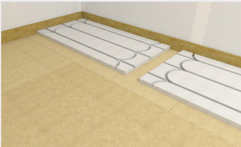
Plaatsing van de fermacell® Therm25™ elementen (variant 1), stotend, in kruisverband tegen elkaar gelegd.
