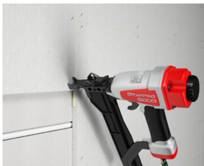
Bevestiging van de bijkomende laag fermacell® gipsvezelplaat of Powerpanel H 2 O incl. vogverbinding
