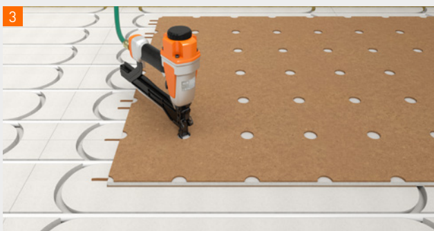
Montage van de bovenplaat en de mechanische bevestiging met schroeven of spreidnieten volgens het sjabloon.
