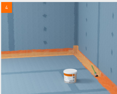
4 De afdichtband direct nadat hij in de folie gedrukt is, met fermacell™ vloeibare folie overschilderen
