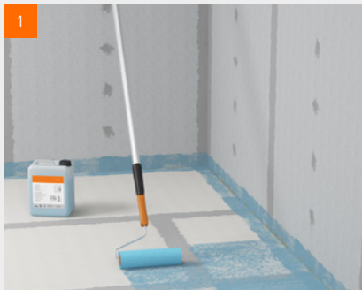
1 fermacell™ diepgrond op de daarvoor aangewezen zones met een rol aanbrengen
