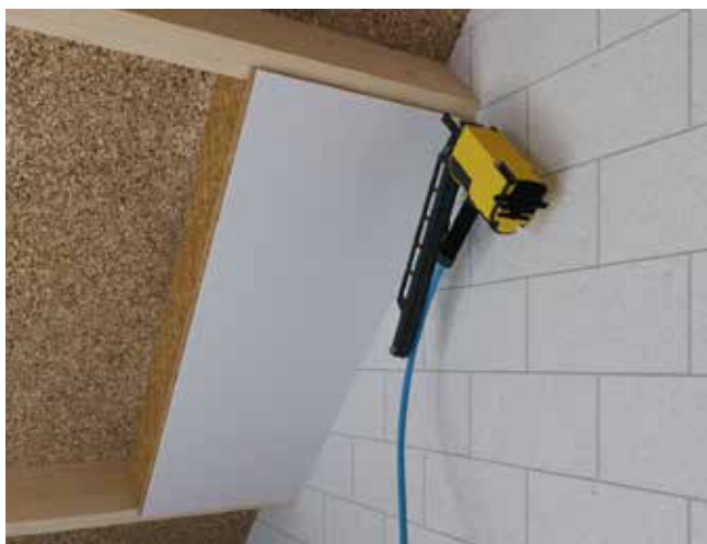
vastzetten hart op hart 100mm
