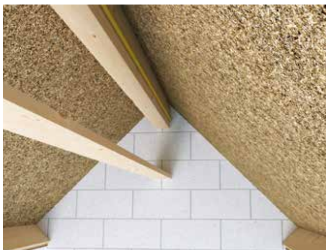
Plaatsen van een lat
