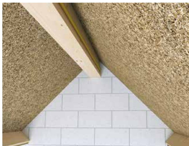
Lat geplaatst in de nok
