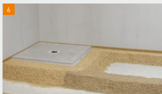
Wacht totdat de dam enigszins is aangedroogd (ca. 20 min.)
