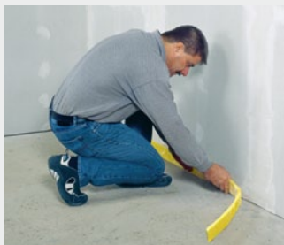
Randisolatiestroken aanbrengen
