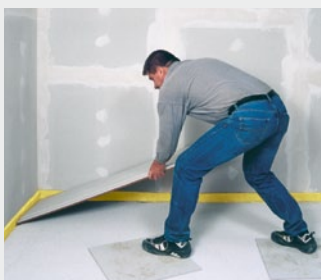
Leggen van de vloerelementen
