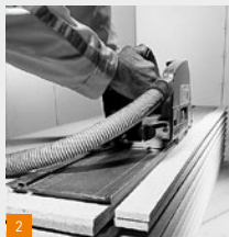
Afzagen van liplas voor eerste rij platen
