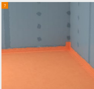
Bij de toepassing van fermacell Vloerlementen van gipsvezelplaten moet er in alle gevallen de fermacell Vloeibare folie ten minste in het sproeibereik volvlaks aangebracht worden.
