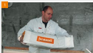
Inhoud van een volle zak in de betonmixer aanmaken
