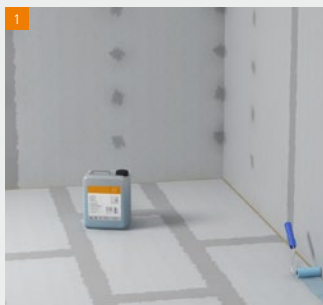
fermacell Diepgrond in de daarvoor aangewezen zones ...
