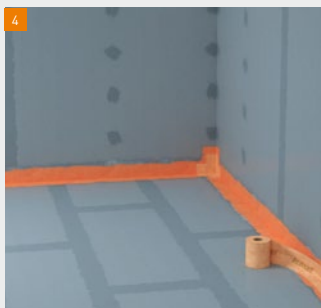
In de nog natte fermacell Vloeibare folie de fermacell Afdichtband drukken.
