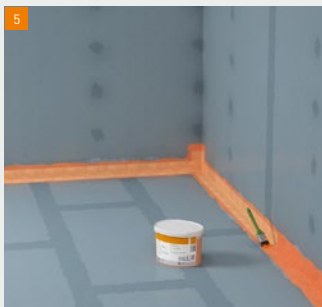
De afdichtband direct na handeling 4 met fermacell Vloeibare folie overschilderen.
