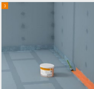
De fermacell Vloeibare folie in de hoeken aanbrengen.
