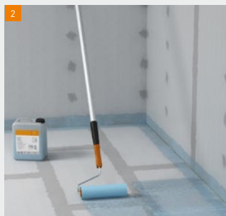
... en met een roller aanbrengen
