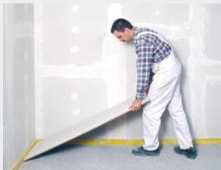
Leggen van de vloerelementen
